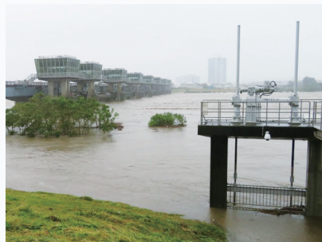
写真2 令和元年東日本台風による相模川の増水・水質悪化の状況 (相模大堰)
