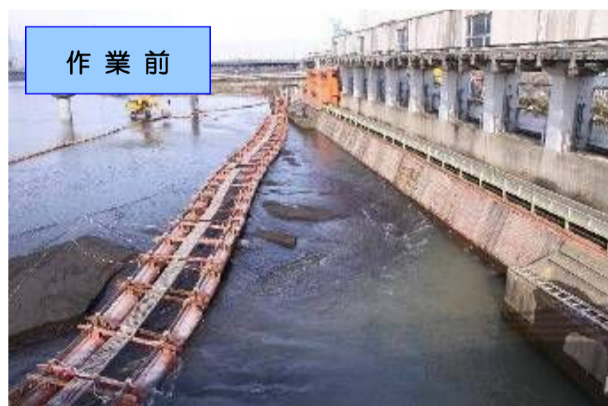
取水口の堆積土砂移動作業（作業前・後）
