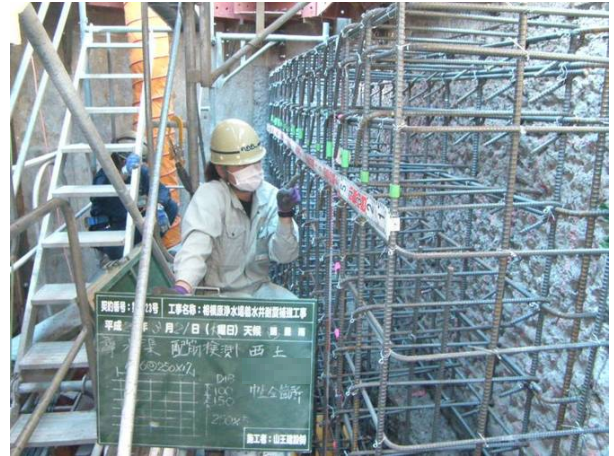
鉄筋組立状況(導水渠)
