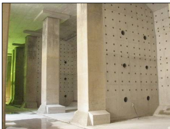
完成状況(耐震壁新設)
