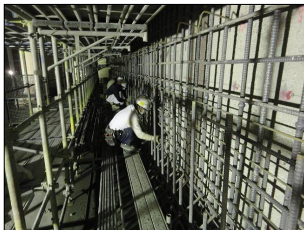
鉄筋組立状況(外壁)
