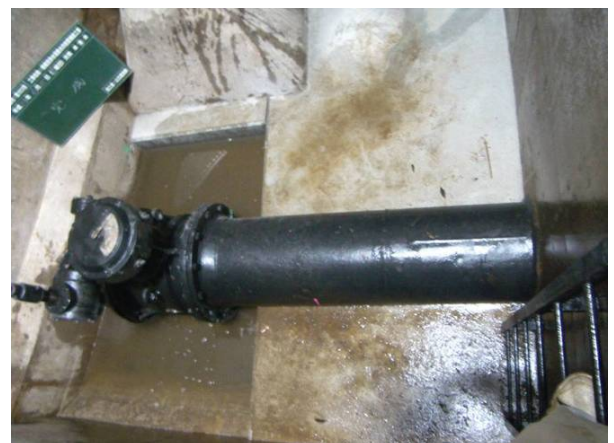
排泥弁室(補強後)
