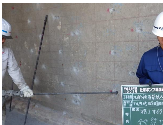
②あと施工せん断補強筋の設置（沈砂池壁への挿入）
