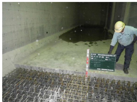
④増厚コンクリート（一部）打設完了（床）
