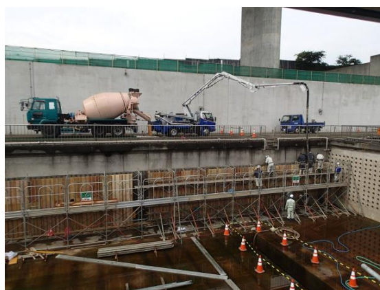
③増厚コンクリート打設状況（沈砂池壁）
