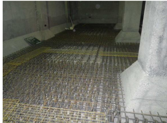
②補強鉄筋組立状況（床）
