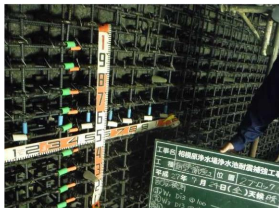
③補強鉄筋組立状況（壁）
