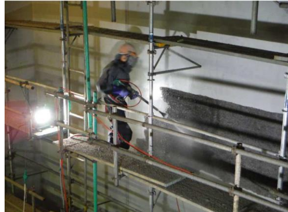
②超高压水での補強箇所の表面処理
