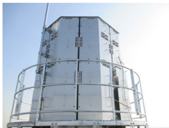
制振装置の設置完了状況
