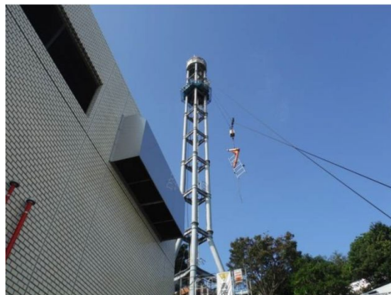
鉄塔頂部への制振装置設置状況
