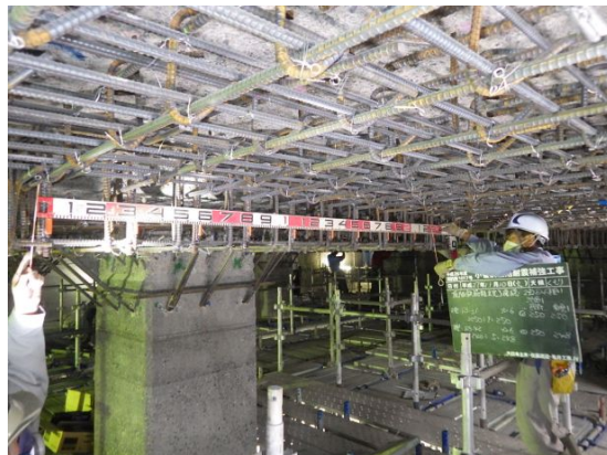
鉄筋組立状況（天井部）
