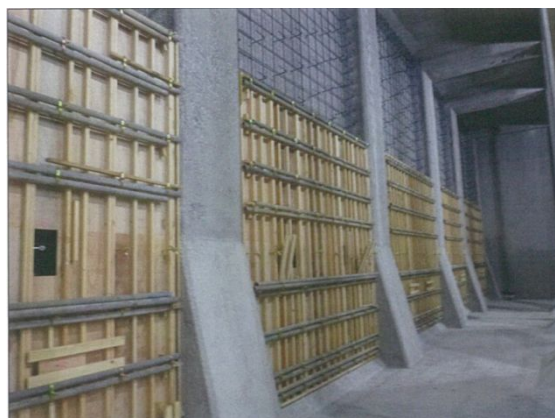
型枠組立状況（壁部）
