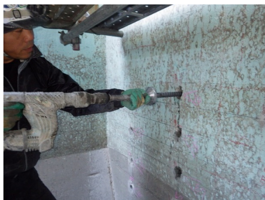
鉄筋打設状況（側壁部）
