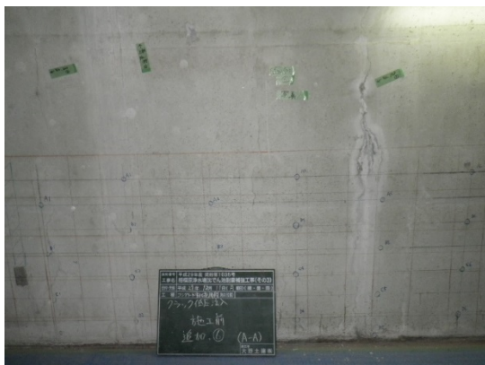
施工前の状況（側壁部）
