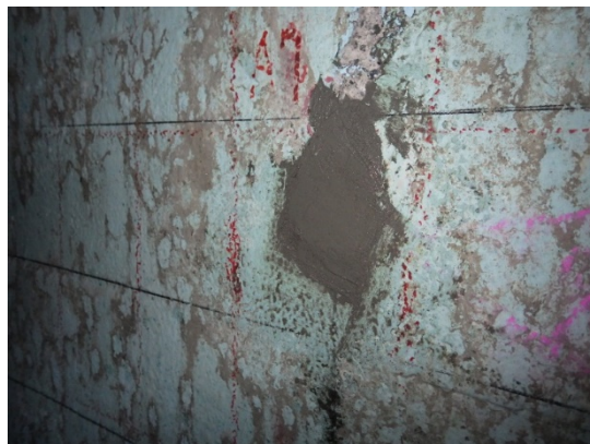
せん断補強筋設置完了
