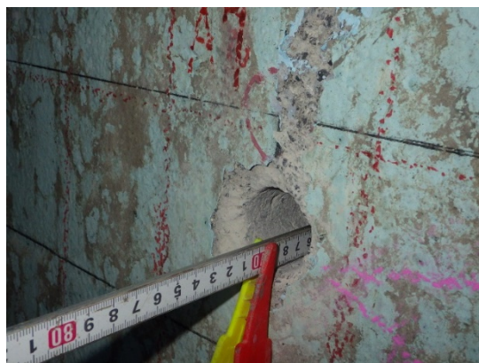
設置孔の削孔状況（側壁部）
