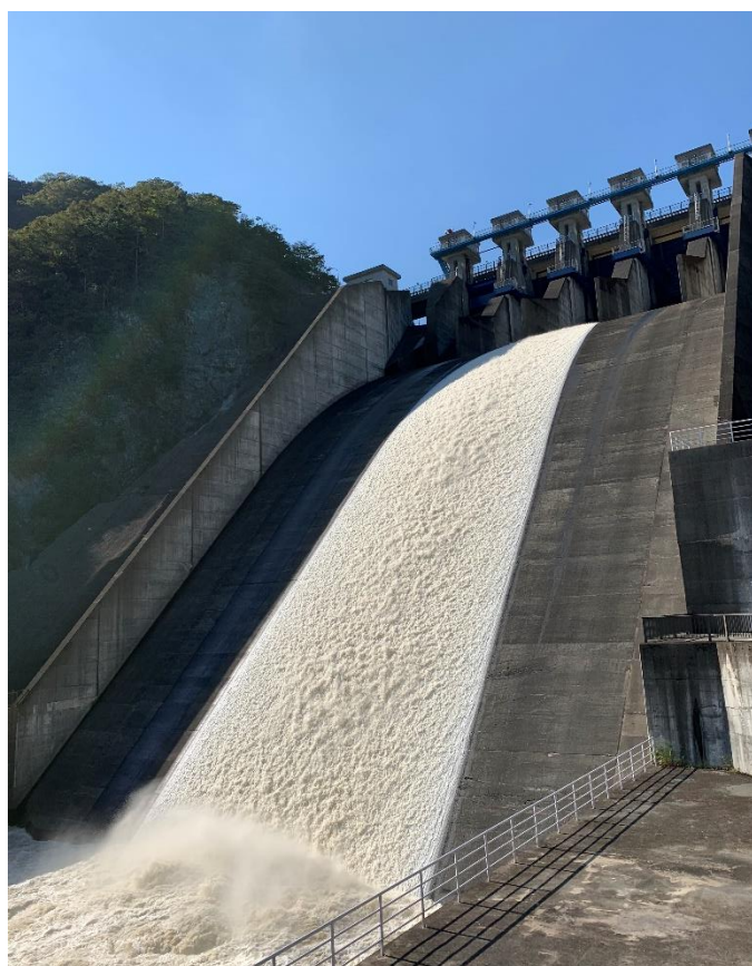
▲ラジアルゲートからの放流 (監査人撮影)
