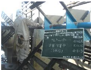
沈でん池内装機器の修繕
