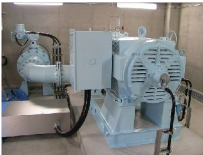
導入した矢指小水力発電所の発電機
