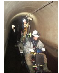
トンネルの内部点検イメージ※1
