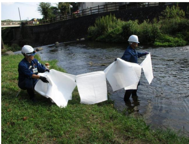
写真6 水源河川に油が流れた場合を想定した オイルマット設置訓練の様子
