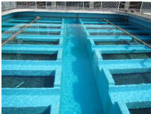
施設の長寿命化(1) (ろ過池 防食塗装修繕事例)
