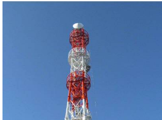
無線通信設備（パラボラアンテナ）
