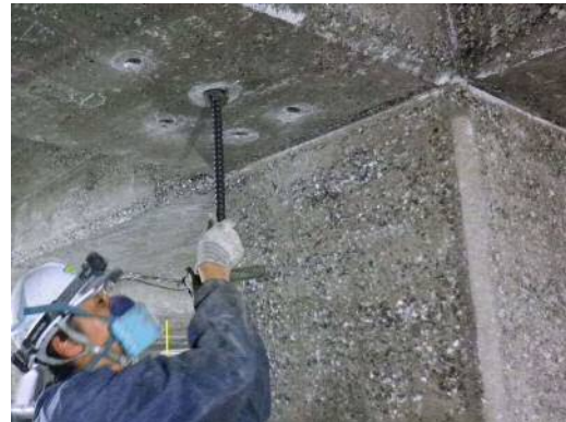
耐震補強工事(2) (梁 あと施工せん断補強鉄筋挿入事例)
