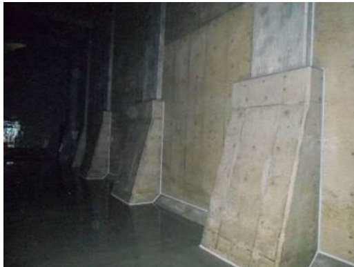
耐震補強工事(1) (壁・柱[下部] 鉄筋コンクリート増厚事例)
