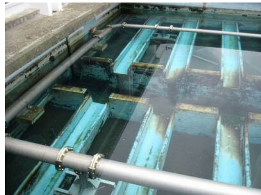
施設の長寿命化(2) (ろ過池 表面洗浄管修繕事例)
