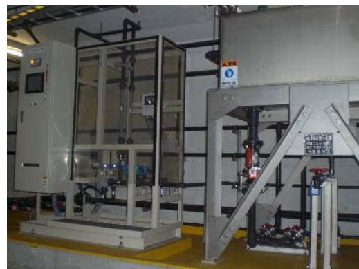
薬品注入設備（次亜塩素酸ナトリウム）
