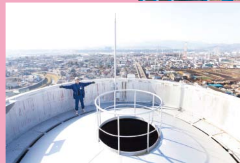
相模原調圧水槽の上部。中央のほか、外壁に沿うように、円状の空気穴が開いている
