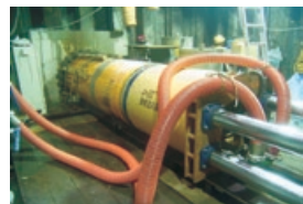
厚木市水引地内配水管布設工事(推進工法) (布設管口径 500mm、さや管 内径 900mm)
