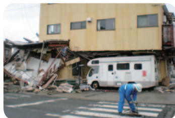
音聴棒を使って漏水調査を体験。音の違いで漏水箇所がわかる(上)。企業団が備蓄している6リットル入りの給水袋。簡単に組み立てることができる(右)
