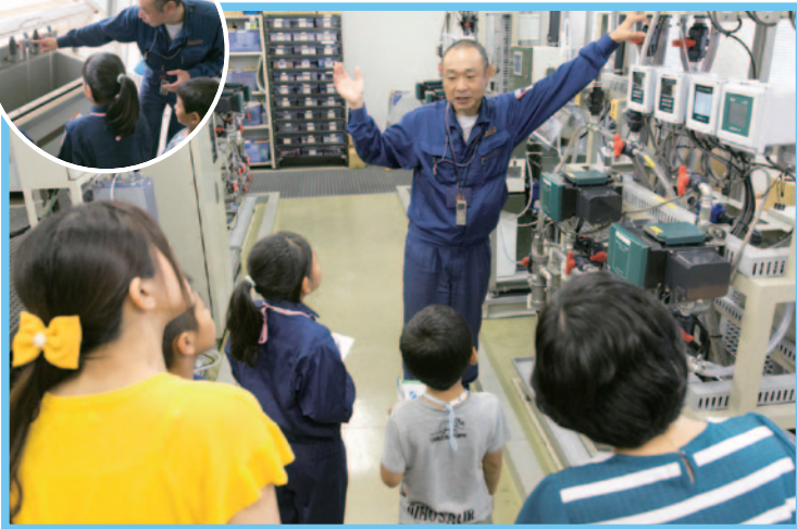
「水質計器室」。計器による水質点検で、いち早く川の異常を察知します。人間の感覚で行う臭気試験もあります。(円の中は臭気試験の設備)
