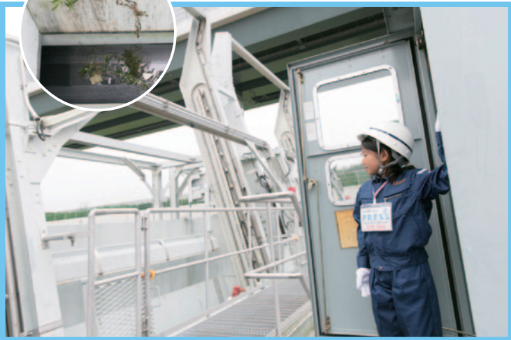
「沈砂池」では「除塵機」の操作を体験。取水された水から大きなごみを取り除かれていく様子(円の中の写真)がよく分かります。
