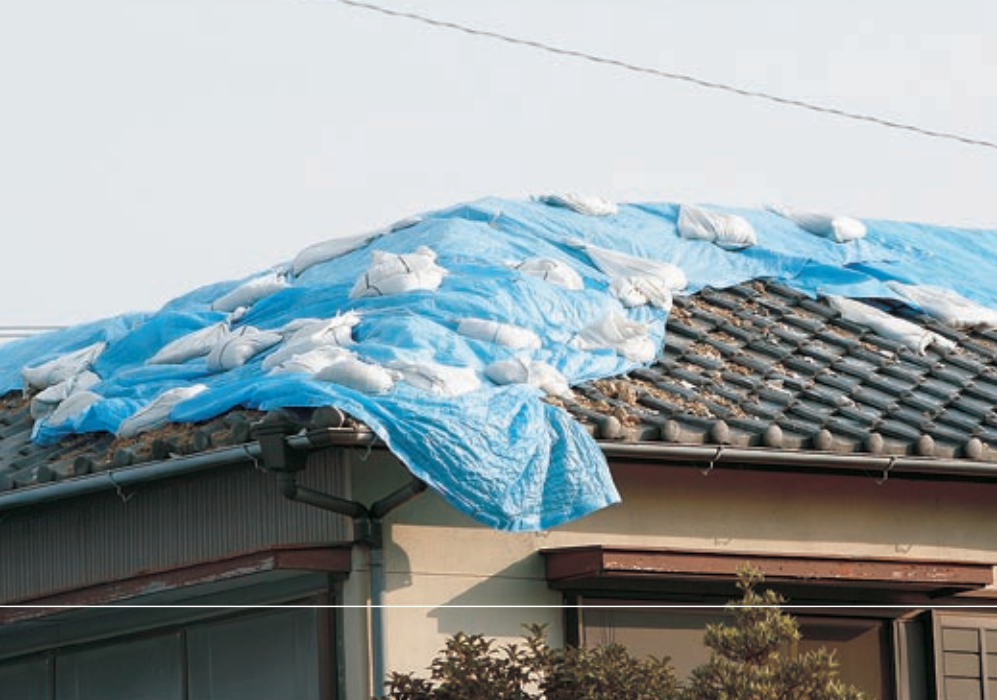
屋根瓦が落ちる被害を受けた家屋が多く、修復途中でブルーシートの応急措置をした家が目立つ
