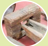
木樋の継手の部分。管と管をつなぐだけのものでした。
