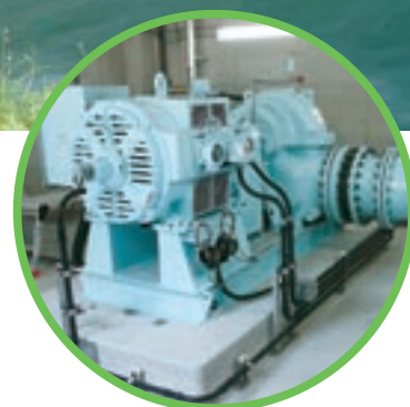
矢指小水力発電所の ポンプ逆転水車発電機
