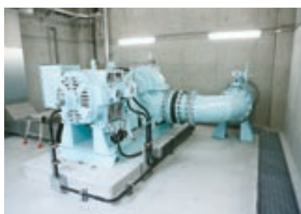
矢指小水力発電所の小水力発電システム。コンパクトでシンプルな構造だ
