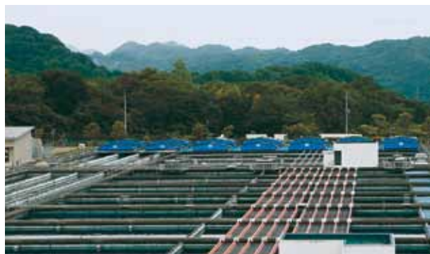
沈でん池、ろ過池の一部に設置された 青いハウス状の太陽光発電のためのソーラーパネル
