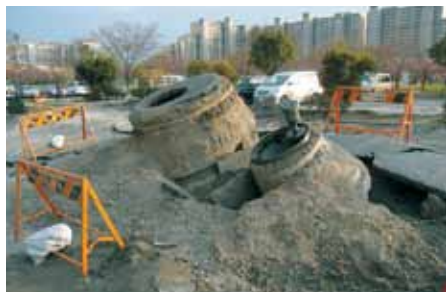
液状化で隆起した消化栓(千葉県浦安市)
