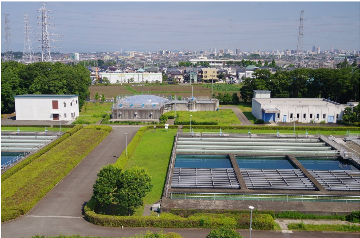
（相模原浄水場 着水井と沈でん池）
