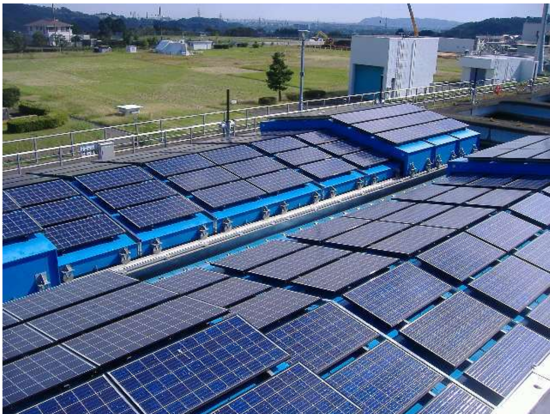
(伊勢原浄水場 急速ろ過池)
