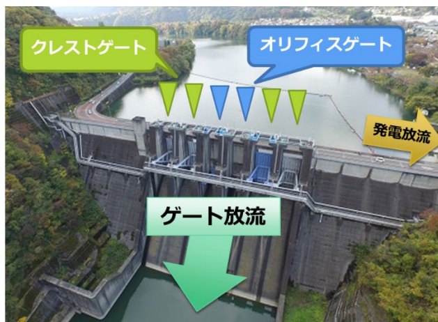
図3 城山ダム外観（神奈川県 HP より引用）
